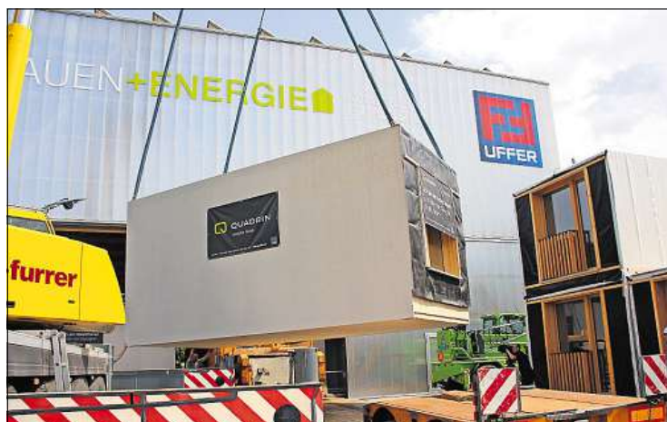
Die 14 Tonnen schweren Module werden mit einem Kran auf den Lastwagen verladen.
