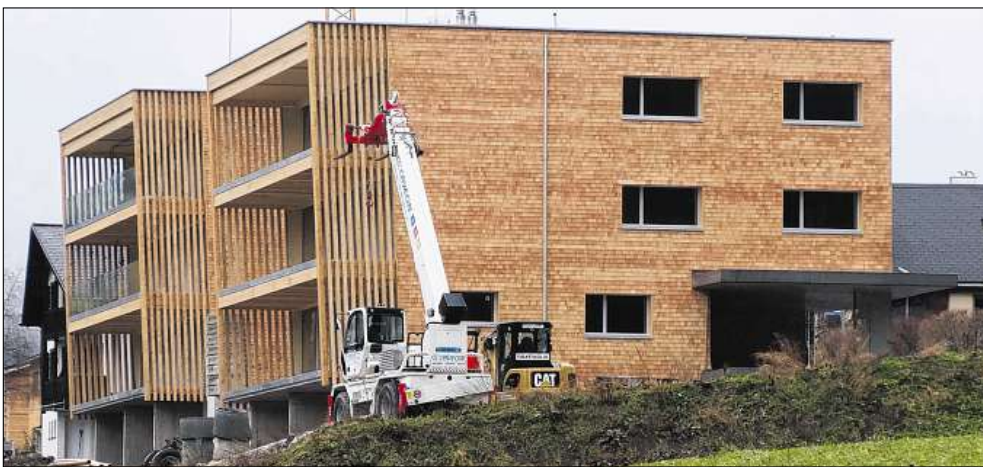
Passivhäuser im Bau in Savognin.
