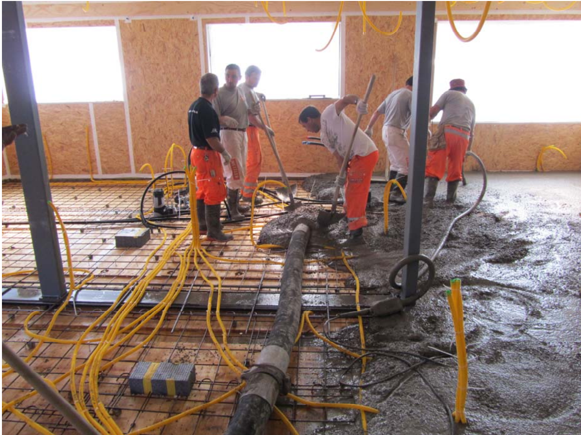
Einbringen des Betons für die Deckenkonstruktion (Foto Uffer AG)
