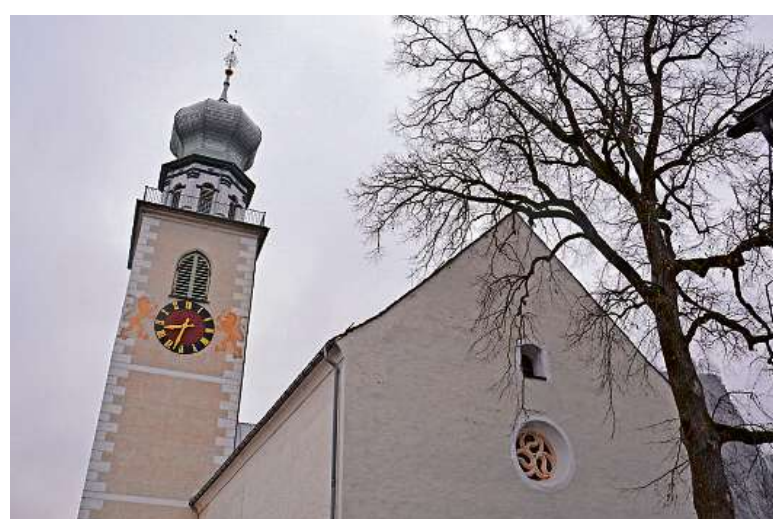
Bleibt dem Glockengeläut vorbehalten: Im Kirchturm der evangelischen Kirche in Thusis wird keine Mobilfunkantenne installiert. (KE)
