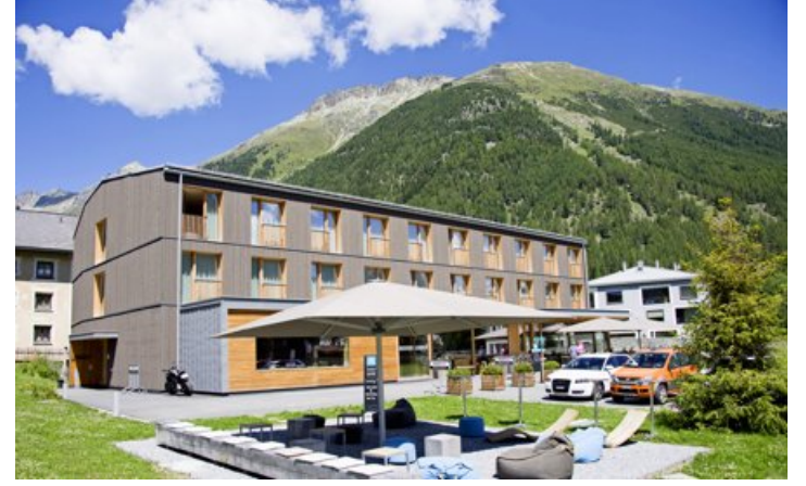
La Bever Lodge est faite de modules préfabriqués en bois.
